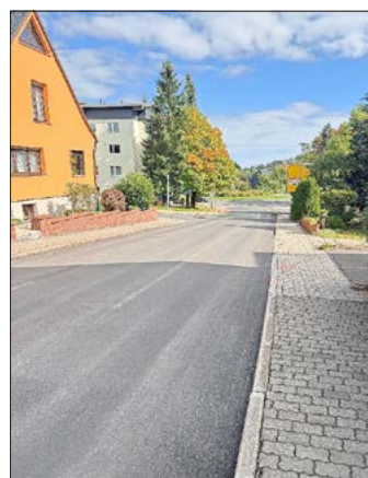
Poststraße nach der Sanierung
