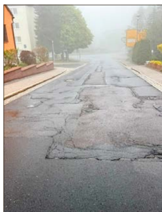
Poststraße vor der Sanierung
