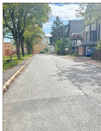
Jägerstraße nach der Sanierung
