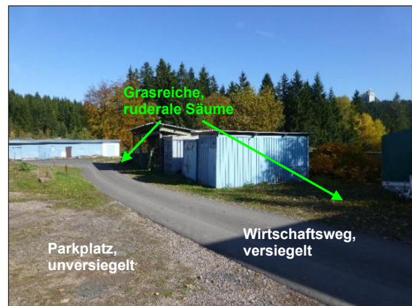
Abbildung 9: Blick auf Werkstatt und Lager im N des Plangebietes
