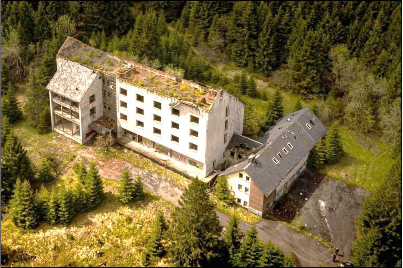
Abbildung 8.1: Foto des ehemaligen „Gästehauses mit angebautem Wirtschaftsgebäude“ [Quelle: OSTARA GMBH; Datum unbekannt]
