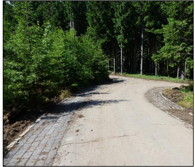
Abbildung 8.5: Foto der „Zufahrt zur Mitarbeiterunterkunft“ [Quelle: KEHRER PLANUNG; 29.06.2021]
